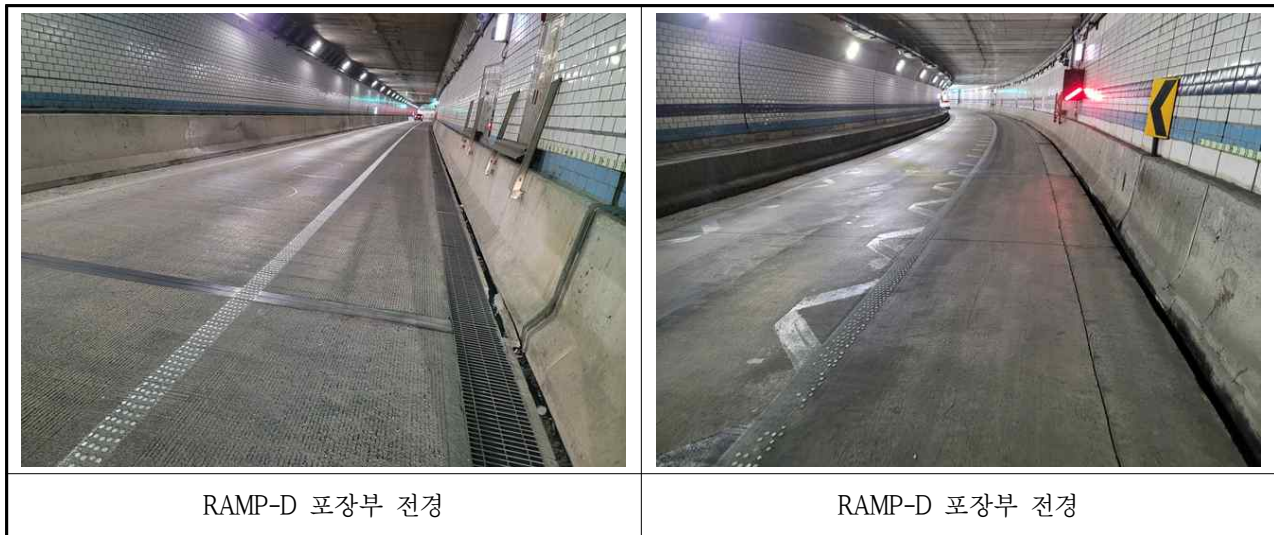
【사진 3.3.29】 포장부 전경
