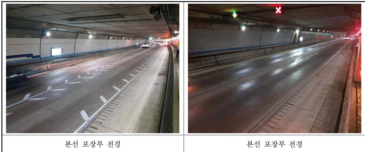
【사진 3.3.11】 포장부 전경
