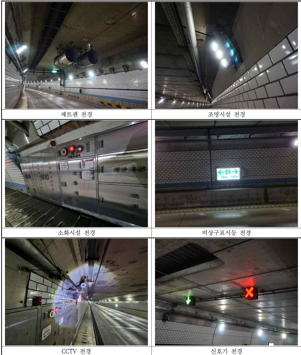
【사진 3.3.43】 부속시설 전경
