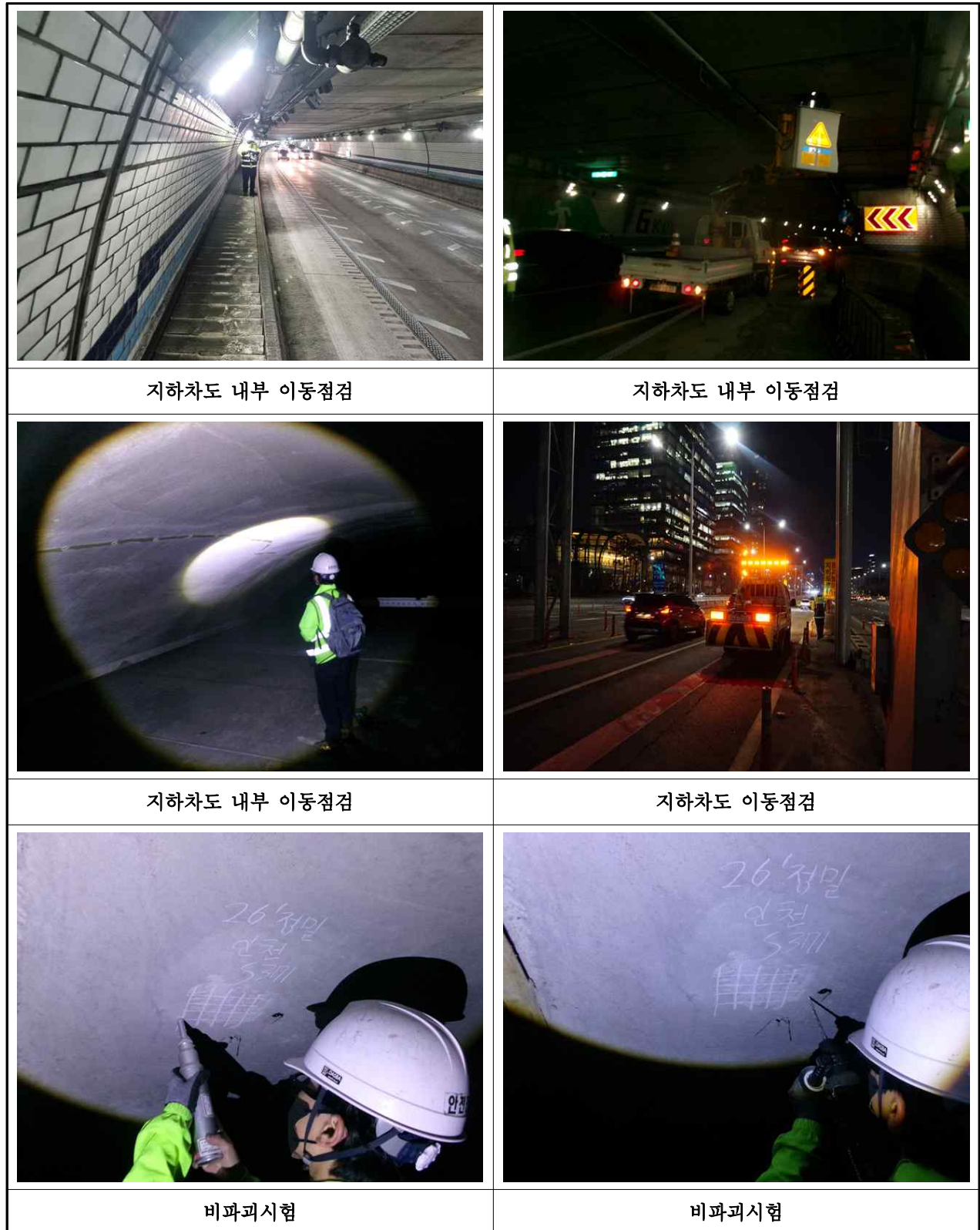
【사진 3.1.1】외관조사 전경
