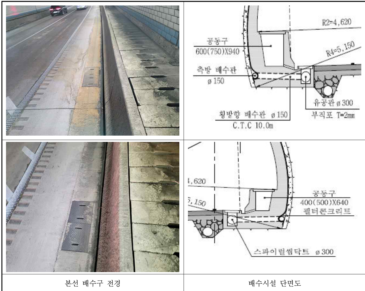
【사진 3.3.15】 배수시설 전경
