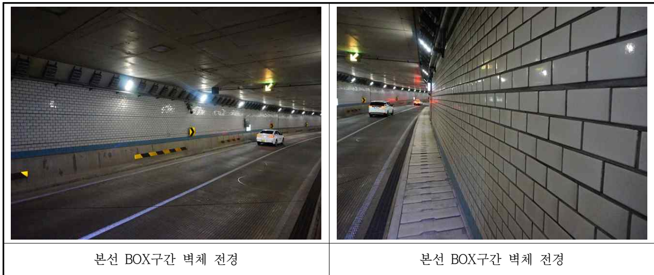
【사진 3.3.3】 BOX구간 벽체 전경
